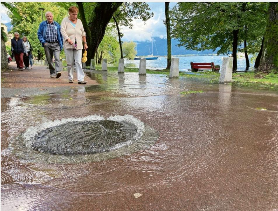
Fig. 2 *Wet-Spot*: Schacht mit Wasseraustritt nach einem Starkregenereignis.
