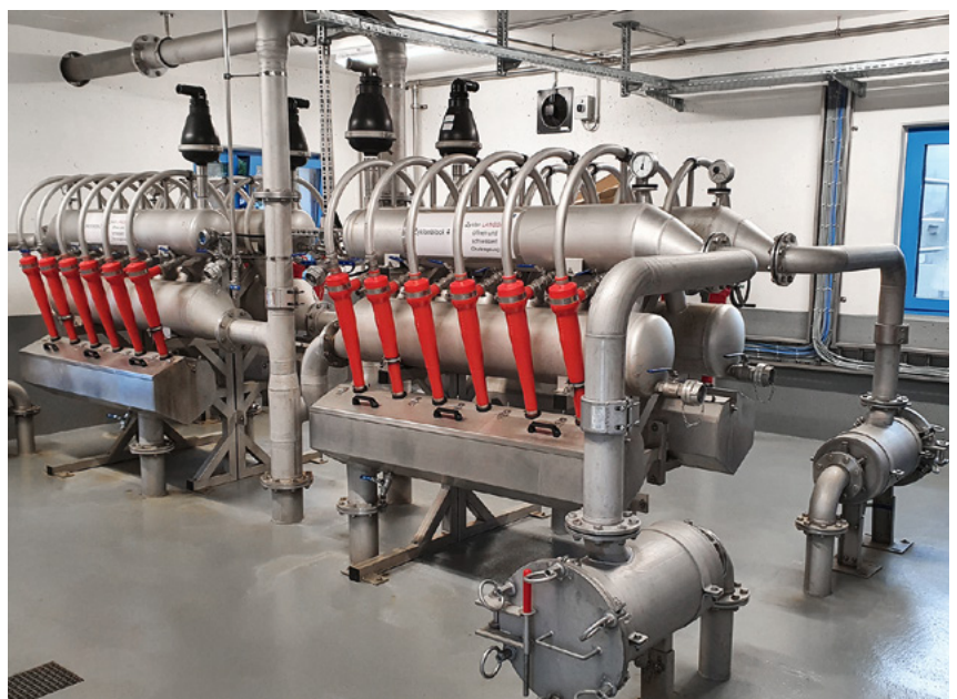
Fig. 4 Zykclonraum mit den vier Zykclonblöcken. Pro Biologiestrasse ist ein Block mit je sechs Zykclonen vorhanden, zulaufseitig jeweils mit Sieb.
