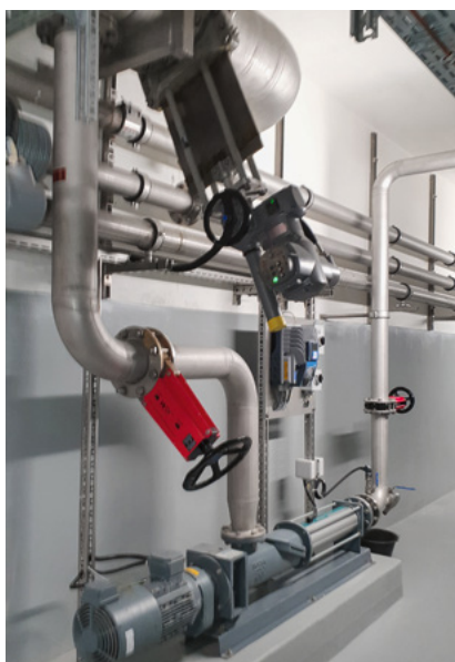
Fig. 3 Beschiebungspumpe eines Zykclonblockes mit saugseitigem Anschluss an RLS-Leitung.
