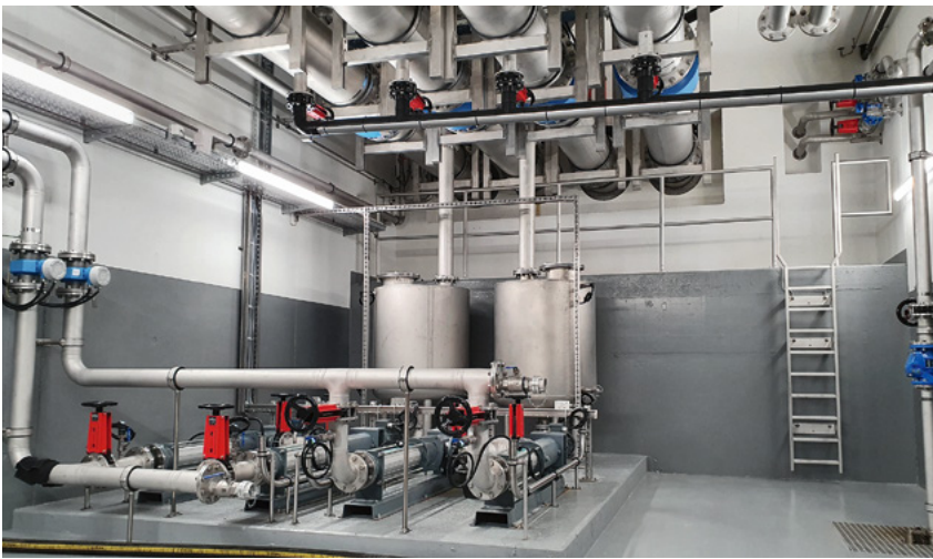
Fig. 5 Zwei Vorlagebehälter mit den Überschussschlammumpfen (zwei Pumpen pro Vorlagebehälter), an der Decke die Zulaufleitungen zur Biologie mit den MID-Durchflussmessungen.
