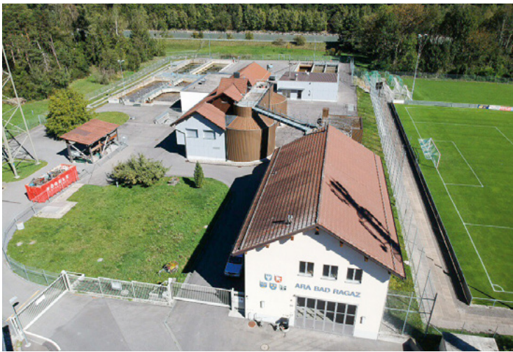
Fig. 4 Übersicht ARA Bad Ragaz mit dem Rhein im Hintergrund
