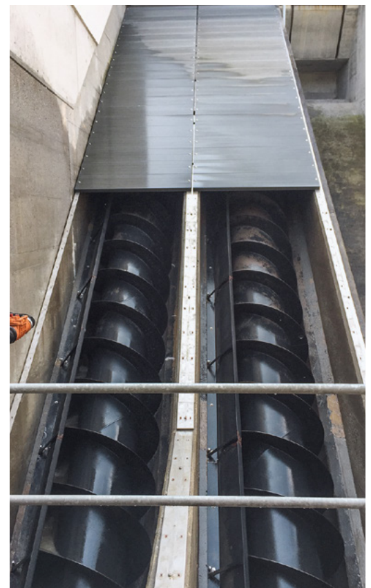
Fig. 3 Zentral ist beim Versuchsbetrieb das Hebewerk. Es wird nachts bei Trockenwetter und günstiger Wetterprognose ausgeschaltet.
