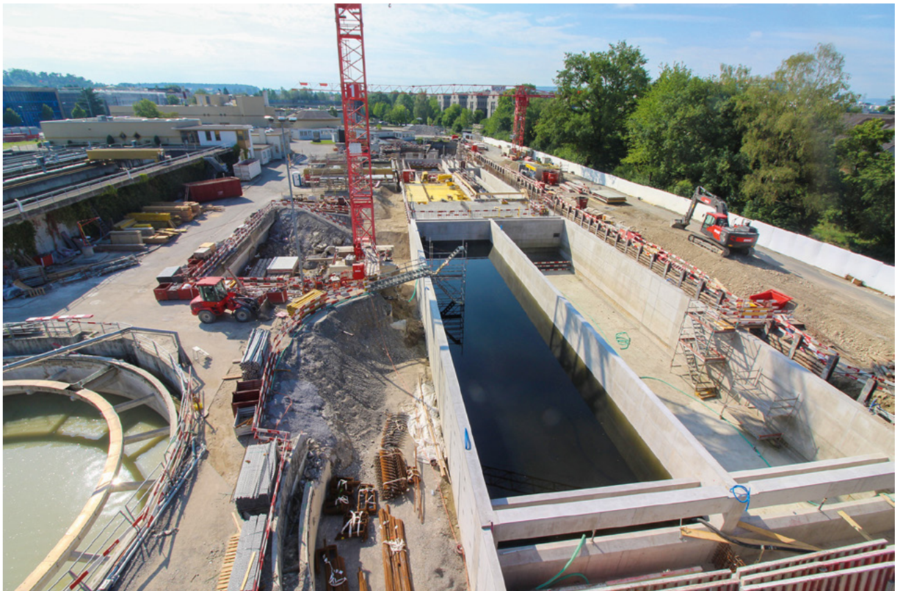
Fig. 2 Das Ausbauprojekt der AKO wird derzeit realisiert.
