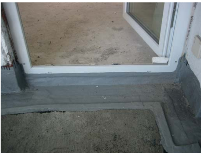
Abb. 19: Abdichtung an einem Fenster über einem Flachdach
