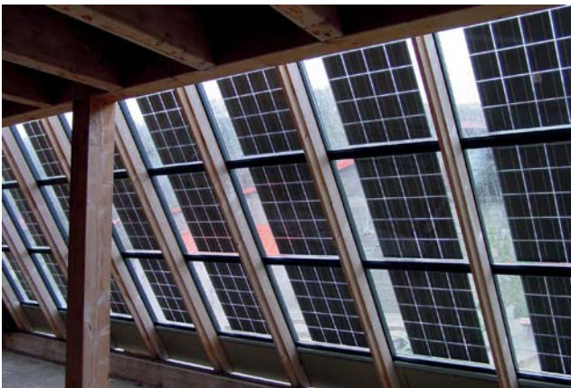
Abb. 11: Photovoltaik Elemente integriert in Glasdach
