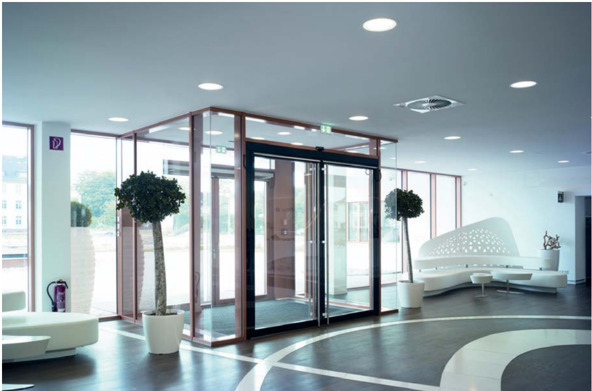
Abb. 22: Windfang mit zwei Schiebetüren
