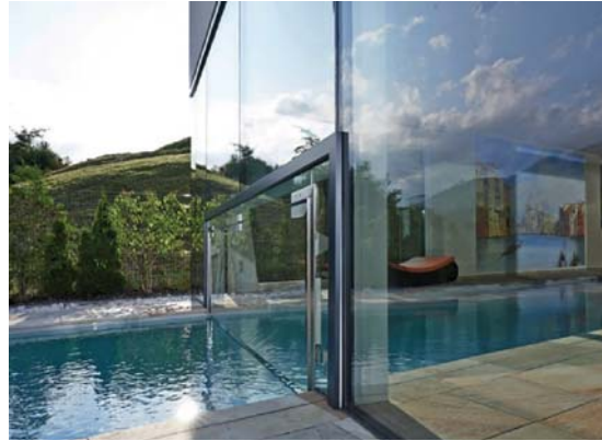
Abb. 24: Schiebetüren unter Wasser ins Ausschwimmbcken
