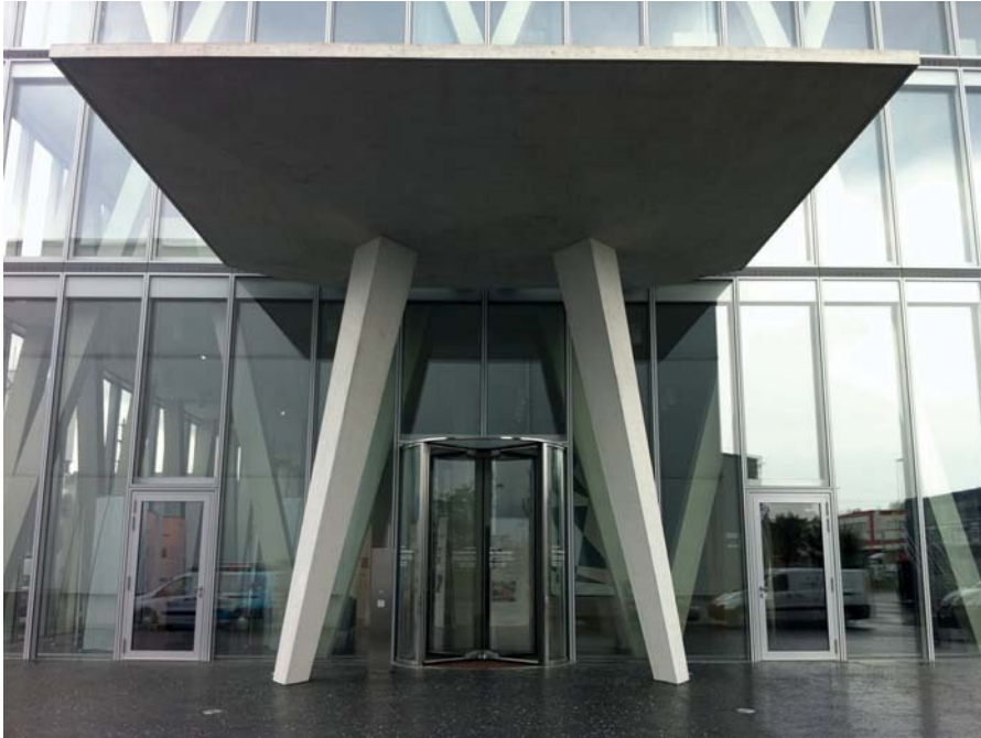
Abb. 27: Drehtüre mit zwei seitlichen Türen zur Entfluchtung und für die Barrierefreiheit
